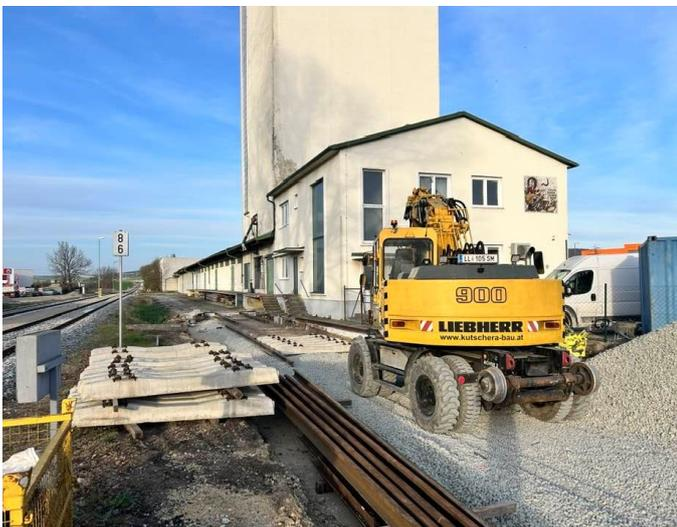
Hier verlegt gerade ein Bagger die neuen Gleiskörper beim Lagerhaus in Rückersdorf
