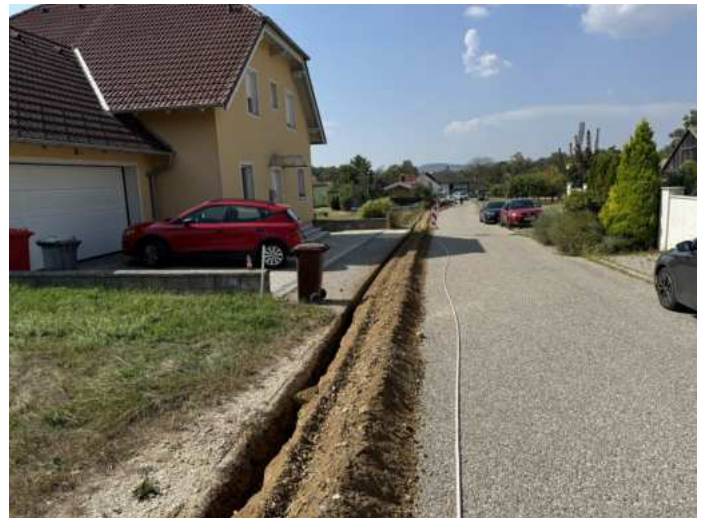
Eine offene Künette bevor das Kabel verlegt wird
