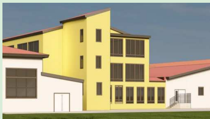
Ansicht von der Hinterseite: Vergrößerung des Speise-saals, Vergrößerung der nördlichen Klassen sowie Schaf-fung einer zweiten Fluchtmöglichkeit
