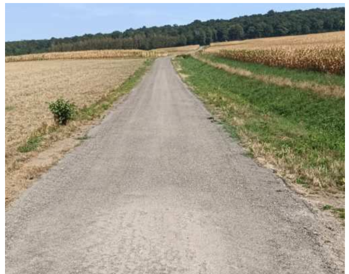
Der frisch sanierte Himmelweg
