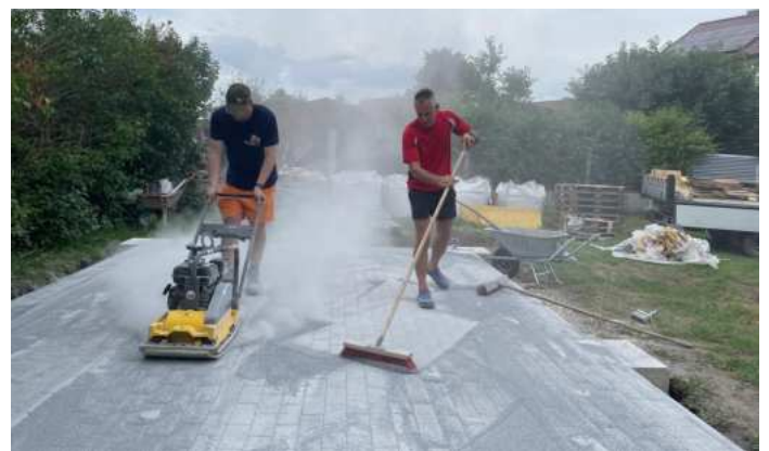
Personen v.l.n.r.: Bgm. Alexander Raicher und GfGR Peter Schagerl beim Abschluss der Pflasterarbeiten
