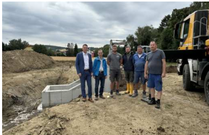
Personen v.l.n.r.: Bgm. Ing. Alexander Raicher, HR DI Thomas Rögner (WA3 – Mistelbach), Rene Schodl, Josef Brunner, Dietmar Weiss (Flussbauhof des Landes Niederösterreichs) und OV GfGR Martin Eichberger vor dem Auslaufbauwerk beim Regenrückhaltebecken
