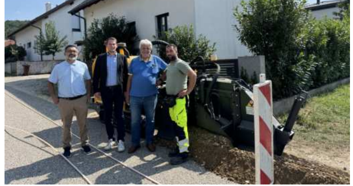
Personen v.l.n.r.: Günet Gencyigitoglu (Speed Connect Austria), Bgm. Alexander Raicher, OV Hubert Krause und Fitim Gashi (Sternnetz) bei den Bauarbeiten in der Gartenstraße
