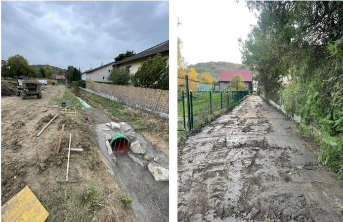
Im Mühlweg wurde ein Teil des Grabens, welcher vom Notüberlauf des Regenrückhaltebeckens weggeht, durch das Team des Bauhofs verrohrt. In diesem Teilbereich kann der Graben mit keinem Bagger sinnvoll gewartet werden, da sich links und rechts Einfriedungen befinden. Aus diesem Grund erfolgte nun die Verrohrung des Teilstück mit einer Gesamtlänge von ca. 100m.
